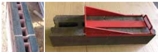
Exemplo de aplicação da argamassa
